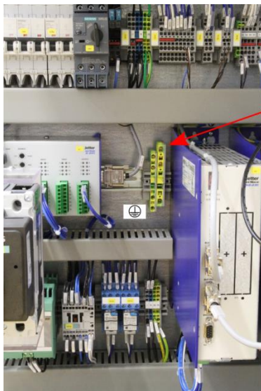
Abbildung 5: Schutzleiterklemme im Schaltschrank
